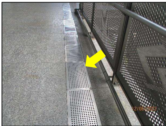
รูปที่ 2-6 ระบบระบายน้ำบริเวณพื้นที่สถานีรถไฟฟ้า
