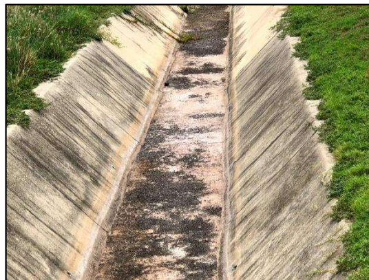
รูปที่ 2-20 การตรวจสอบ ดุแล และขุดลอกที่ระบายน้ำและบ่อกักที่ระบายน้ำอย่างสม่ำเสมอภายในพื้นที่ศูนย์ซ่อมบำรุง
