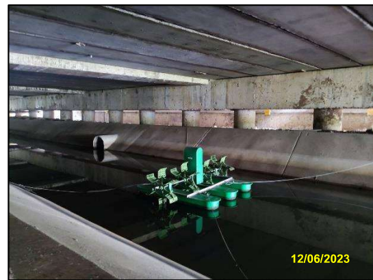
รูปที่ 2-23 การติดตั้งเครื่องเติมอากาศ บริเวณบ่อพักน้ำเสียที่ผ่านการบำบัด ภายในพื้นที่ศูนย์ซ่อมบำรุง
